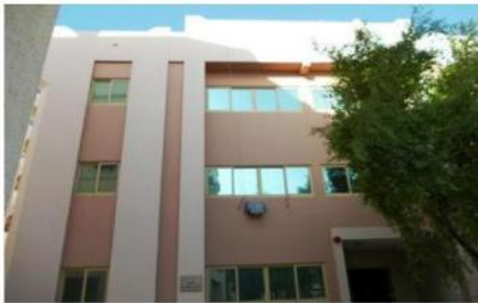
AMAF Khalfan Bin Shanaf 3 Bldg
